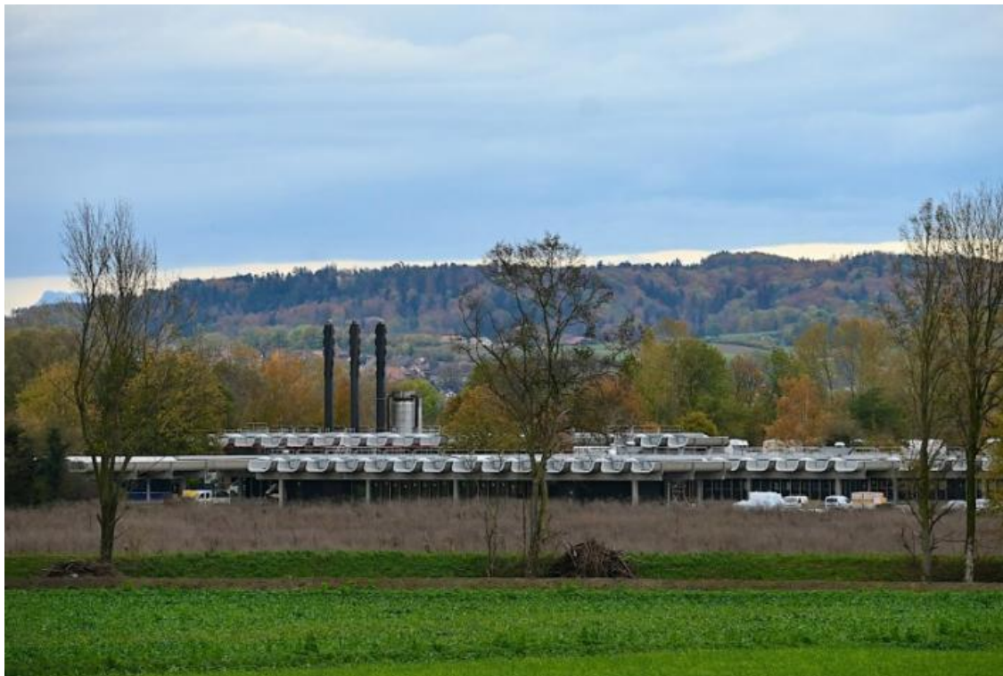
Micarna a acheté le terrain situé à proximité des emblématiques bâtiments protégés de l'Agrico. 39 millions de francs ont été investis pour les transformer. PHOTO JÉRÔME GENET
